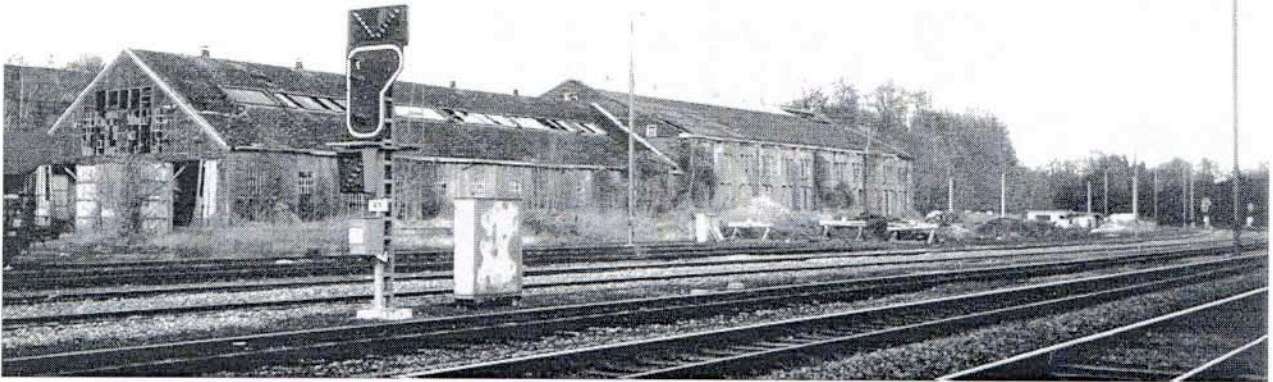
Remise et ateliers à l'arrière-plan avec 3 voies en impasse. A l'avant-plan : deux voies principales aux rails brillants, une voie de débord avec signal lumineux de voie déviée avec armoire de raccords de câbles. A droite vers Pry, à gauche vers Walcourt centre-ville et Vogenée. Le château d'eau est caché par la perspective des anciennes remises et situé au bout du bâtiment de droite (Photo Etienne Dozot)
